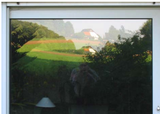
Abb. 1. Die Verformung der Doppelscheiben lässt sich oft an entsprechend verformten Spiegelbildern erkennen.
